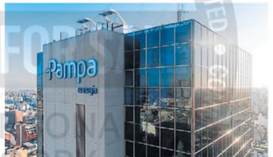
Sede. La vista del "head quarter" de Pampa Energía en Buenos Aires.
