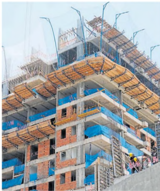
Zona de obra. Hay préstamos para comprar desde los cimientos.
