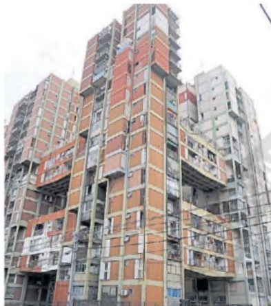
Conjunto Rioja. Los edificios en Parque Patricios.
