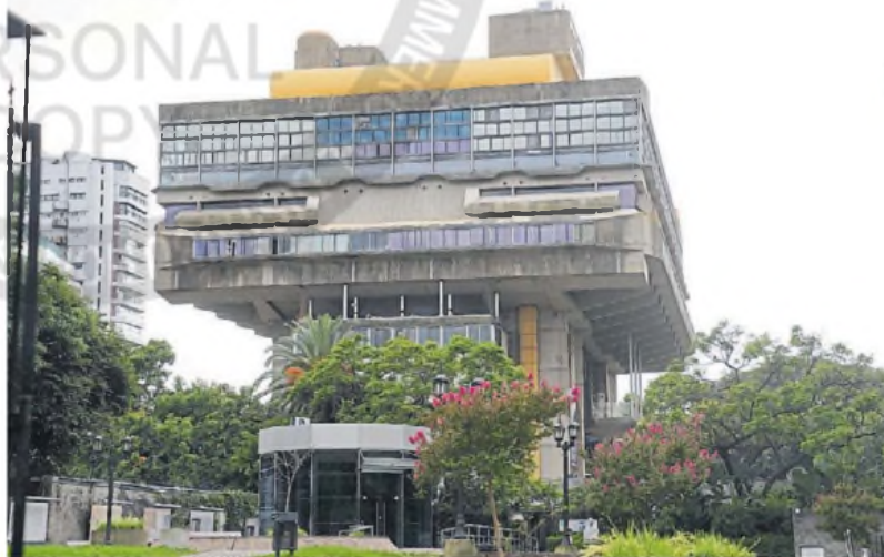
Biblioteca Nacional. La obra de Clorindo Testa es el mejor ejemplo del brutalismo. FOTOS: G. RODRIGUEZ ADAMI
