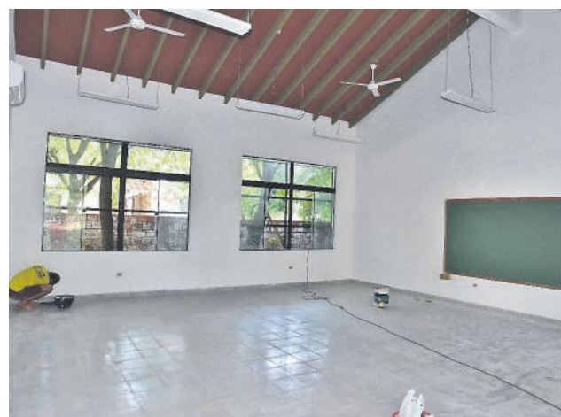
El aula ya está terminada. Ahora faltan mesas y sillas.
