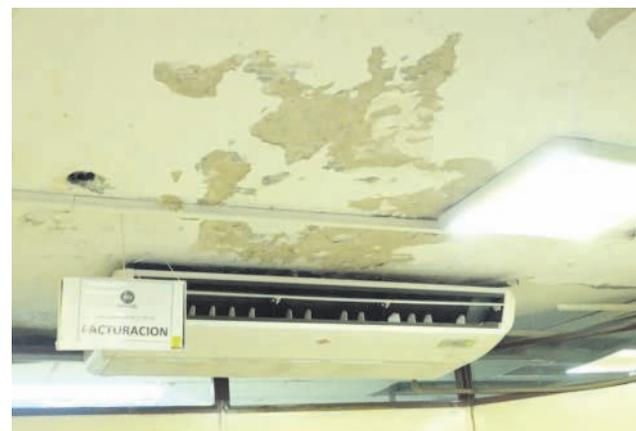
Techo derruido y un acondicionador de aire que no funciona.
