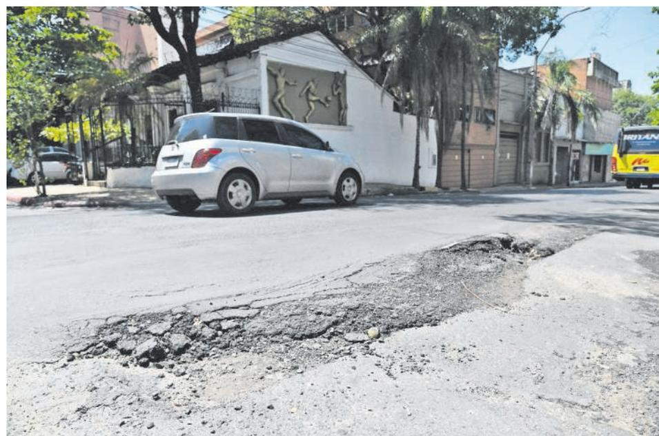
Capa asfáltica sobre la calle Herrera de Asunción con profundas grietas que necesitan reparación.
