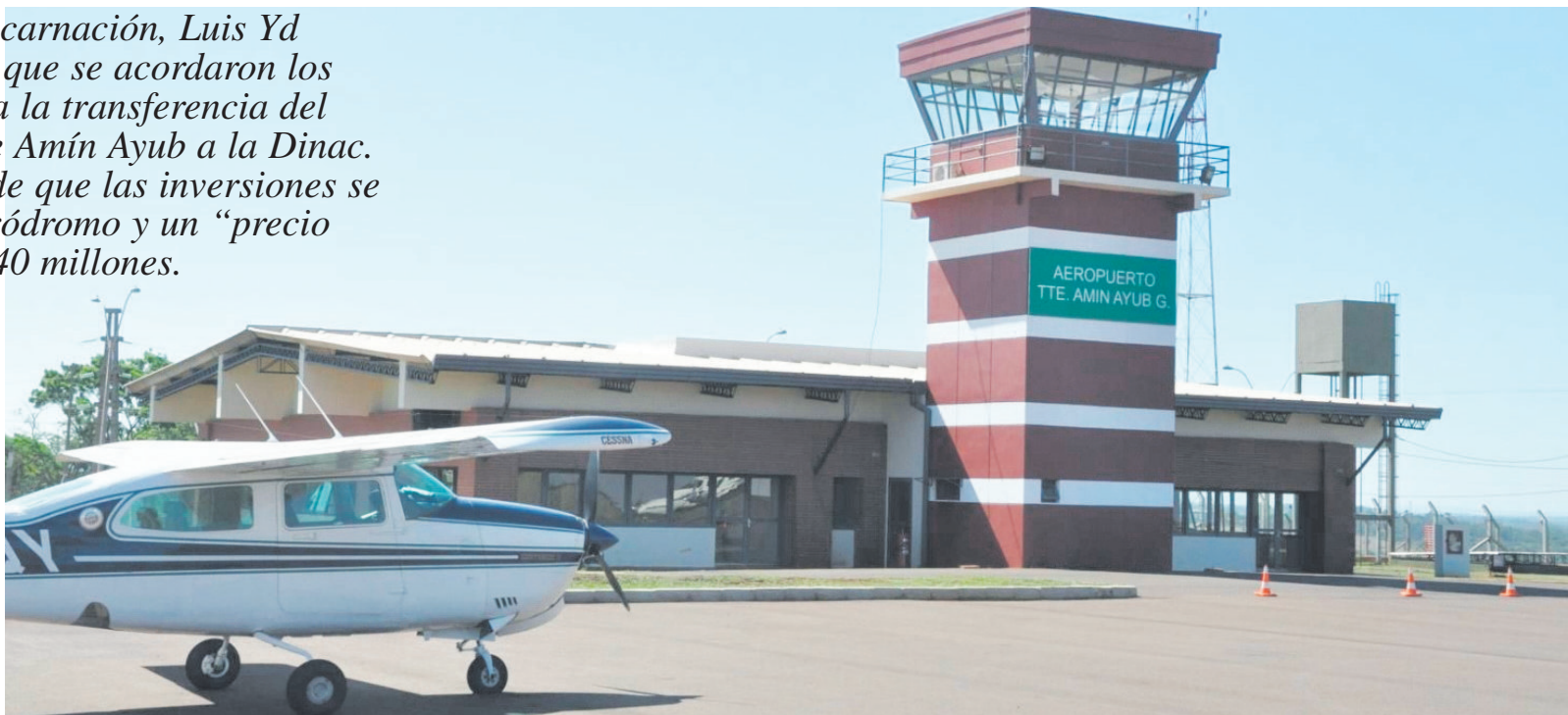
El aeropuerto Teniente Amín Ayub, que sería cedido a la Dinac por la comuna encarnacena.
