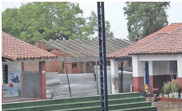
Las dos aulas para el nivel inicial siguen a medio construir.
