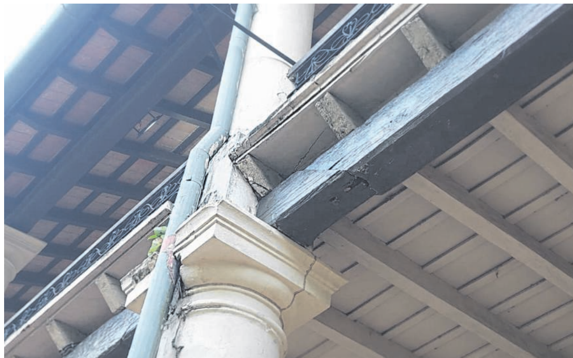
Las vigas que sostienen los balcones de la "Casa Alta" muestran fisuras. El patrimonio está lleno de termitas.
