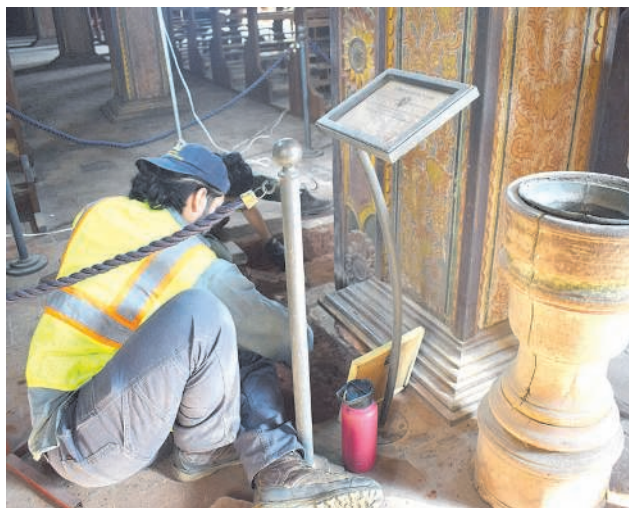
La SNC comenzó a intervenir en el templo de San Buenaventura.
