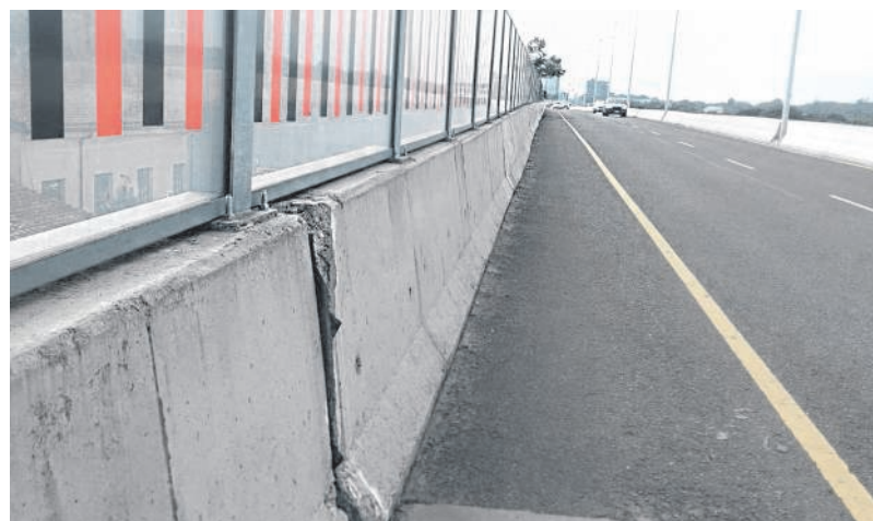
El viaducto principal ya tiene irregularidades y desplazamiento en las paredes.
