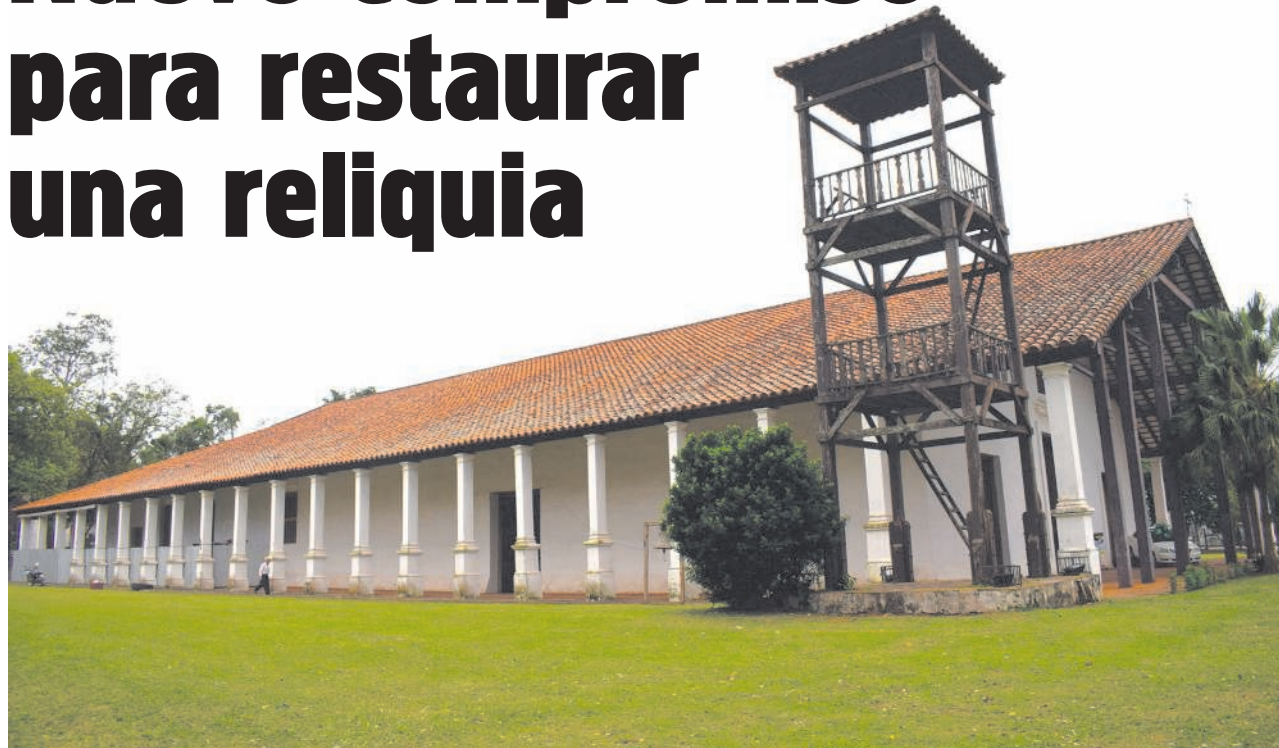
La SNC realiza un diagnóstico de la situación de la infraestructura de la antigua iglesia de Yaguarón.
