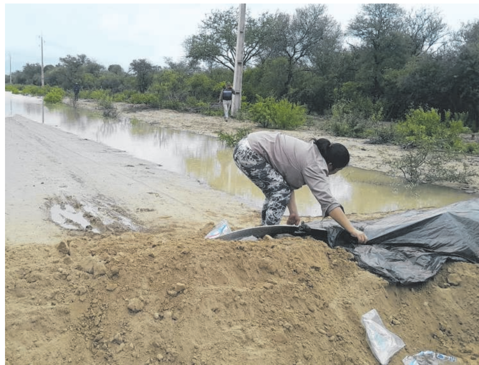
Pobladores de Pozo Hondo se ingenian para construir un muro de tierra de defensa ante la crecida.
