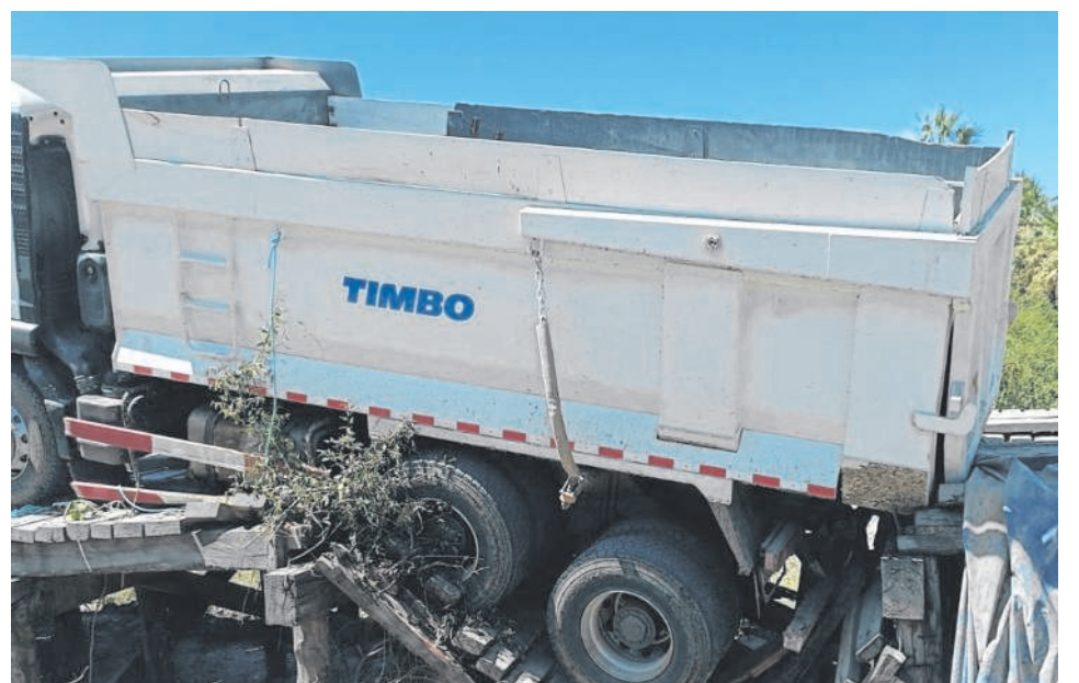
Los puentes de la zona también están en pésimo estado y no aguantan el peso de los camiones.
