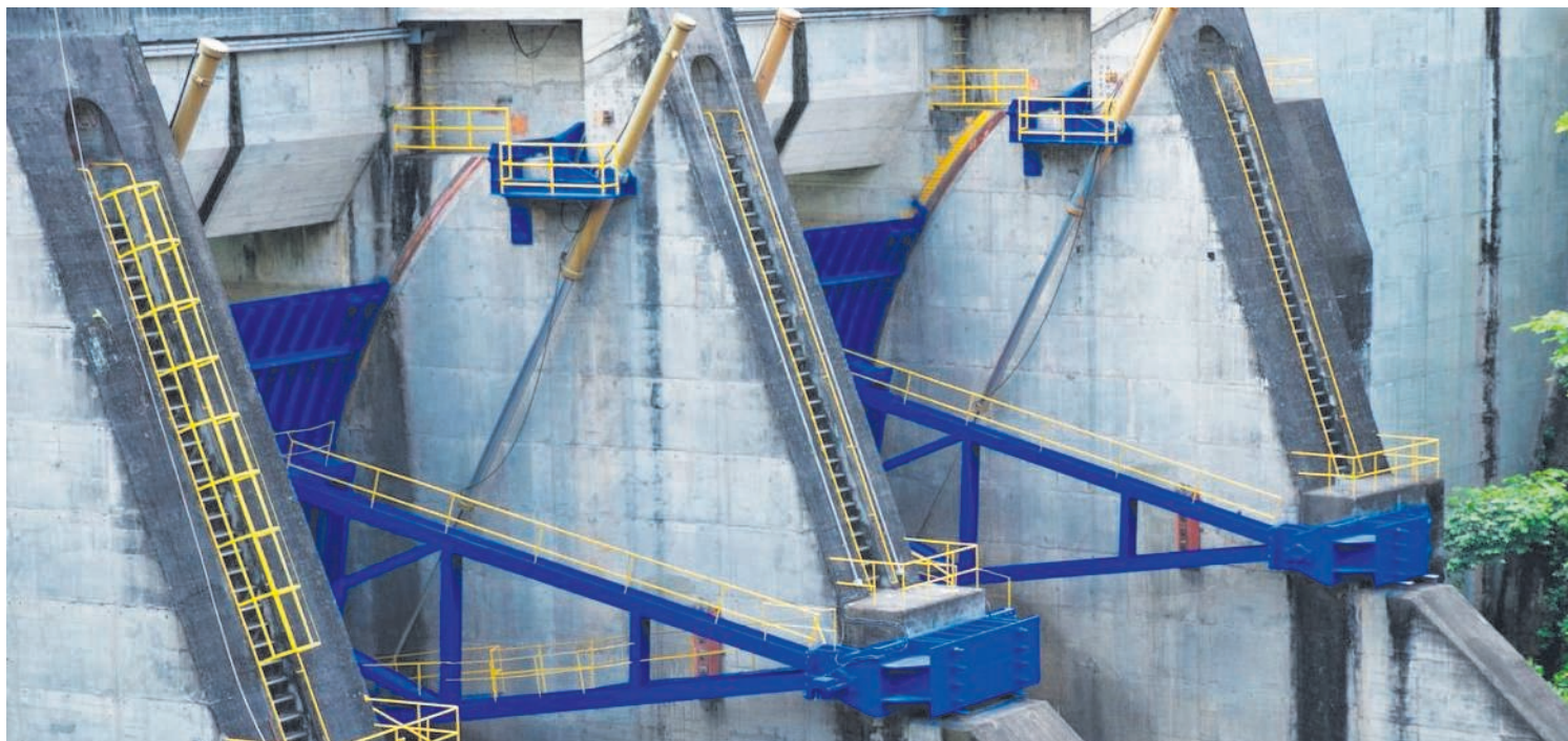
Pequeñas Centrales Hidroeléctricas.
