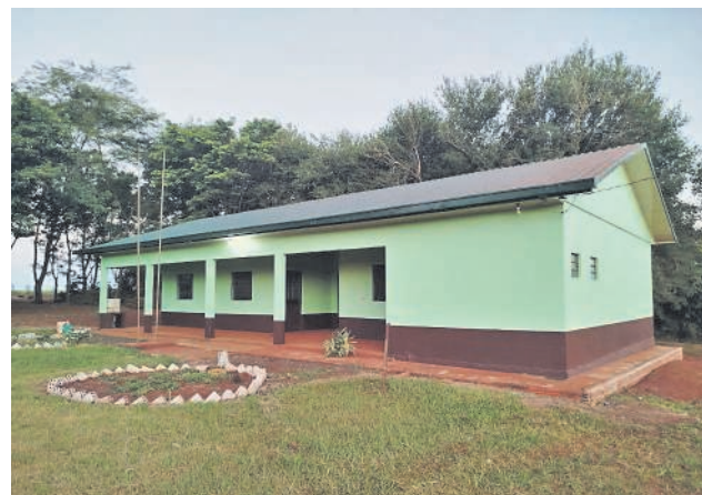
En la refacción de la escuela 5462 se invirtieron G. 67 millones.
