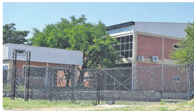
Fábrica de Textil San Francisco, construida por Itaipú Binacional.
