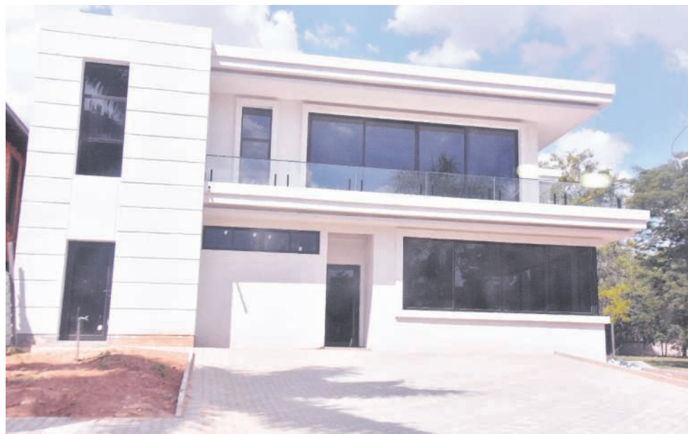
El senador cartista vive a escasos metros de su residencia en construcción, por lo que constantemente visita la zona de obra.
