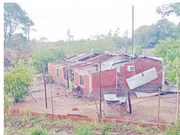
Una de las viviendas destechadas en la comunidad de Primavera, en Paso Horqueta.
