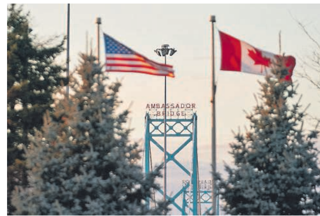
Puente en Windsor, Ontario, límite entre EE.UU. y Canadá.
