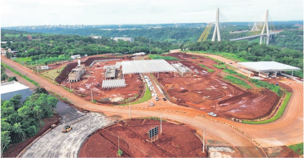
La construcción del Puente de la Integración está terminada, pero su apertura depende de que culminen las obras complementarias.
