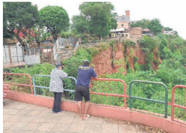
El mirador de Itapytãpunta está en riesgo, con 22 viviendas.
