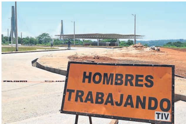
Las obras complementarias tienen mayor avance en Paraguay.
