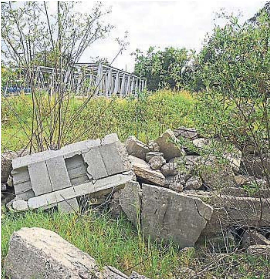
ESCOMBROS. En varios sectores hay bloques de hormigón de viejas obras que nunca fueron retirados.
