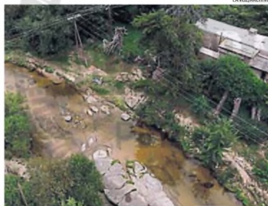
EL PUNTO. La planta de cloacas de La Cumbrecita, junto al cauce del Río del Medio
