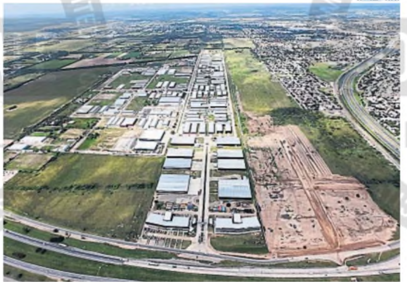
PROYECTO. Junto al parque industrial, Polo 52 ya comenzó a preparar el terreno para empresas de construcción y decoración.
