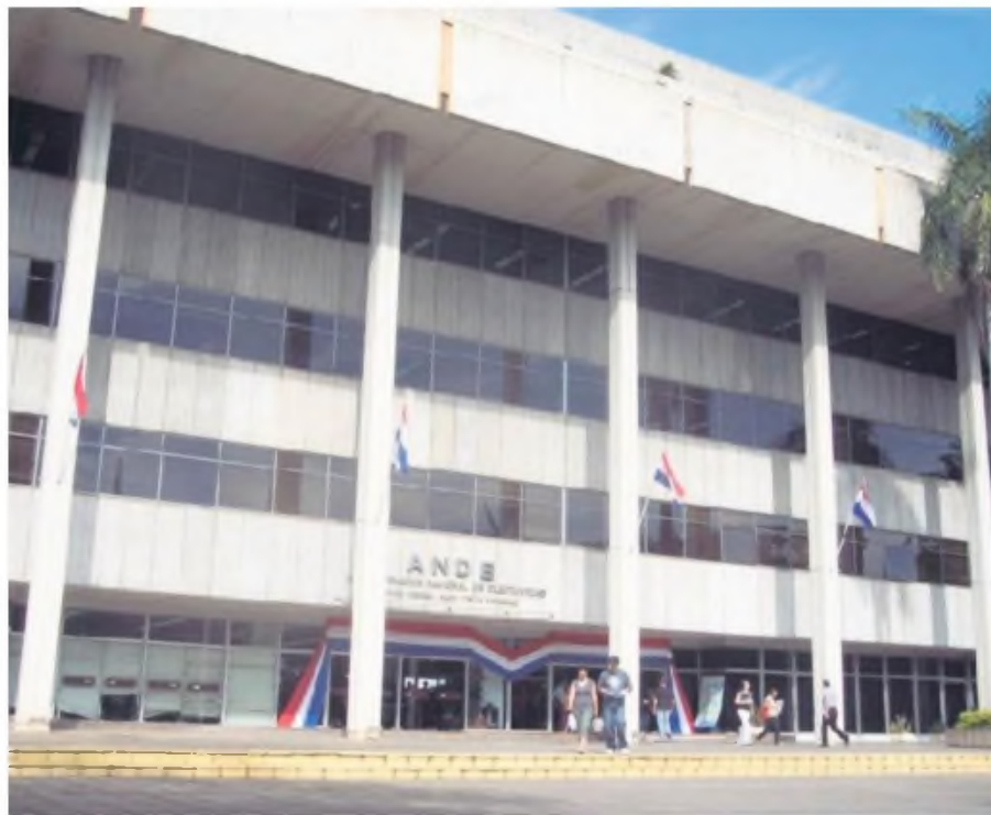
La ANDE se encuentra en proceso de ejecución de obras por US$ 590 millones.
