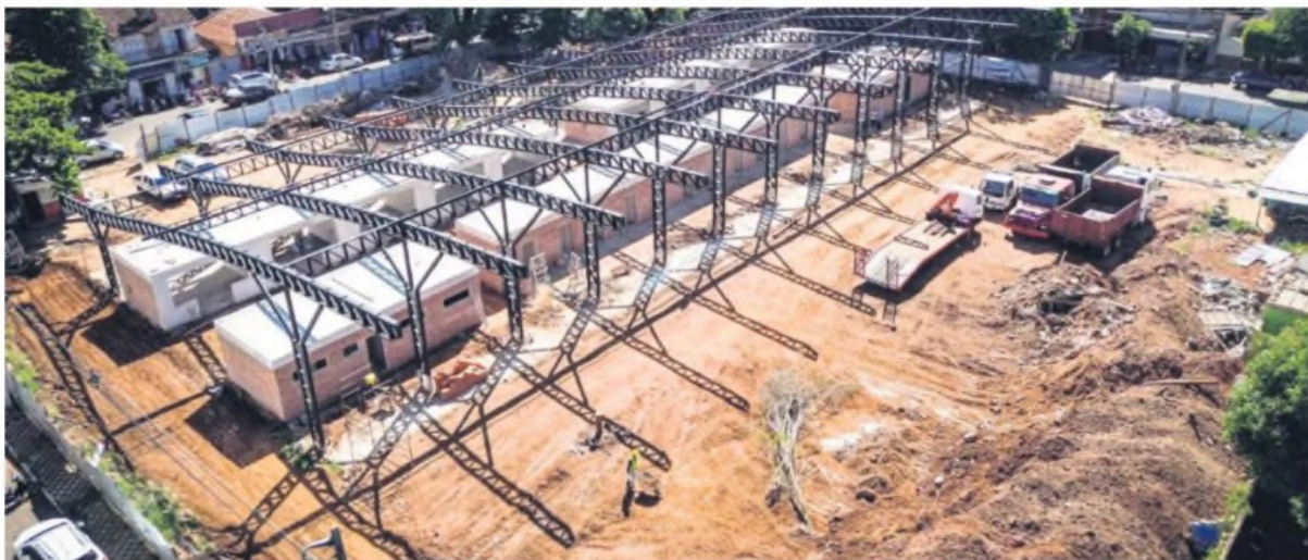
La obra genera una gran expectativa en los usuarios.
